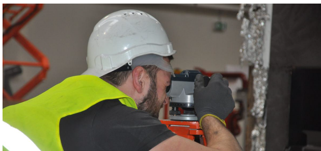
Mit Lasertechnik wurde die exakte Position des neuen Ofens bestimmt. © Griese
