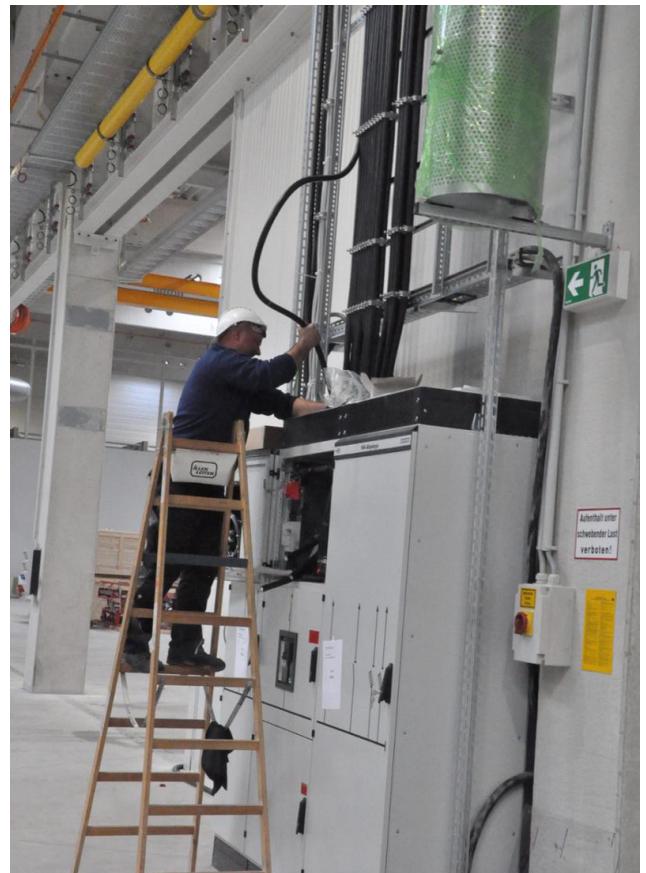
Arbeiter der verschiedenen Lieferanten sind derzeit damit beschäftigt, die Anlagen und Maschinen einzurichten. © Griese
